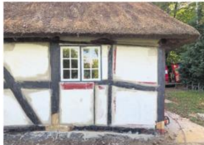
Bemærk, at det på den ældste side af lejrskolen har været nødvendigt at fjerne al den løse røde maling, for at reparere bindingsværket, der for år tilbage har været sort. Det er det, som ses på disse billeder.
