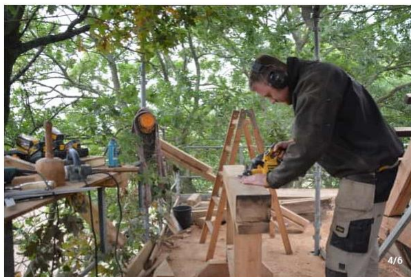
At renovere et helt kirketårn i bindingsværk er ikke en opgave, der må sløses med. Det kræver, at man er meget omhyggelig, siger tømrer Kristoffer Klausholm. Foto: Sandra Goldek
